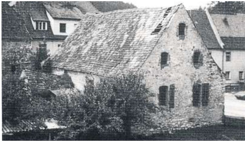
Das Kommunbräuhaus in Schmidmühlen. Es wurde 1987 abgebrochen. Es diente bis 1812 als Gerichtsgebäude.
